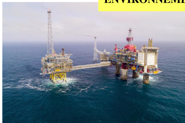
Plateforme de Sleipner en Norvège. © Equinor
