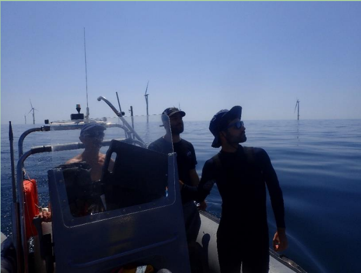
Parc éolien de St Nazaire le 23 juin 2023
